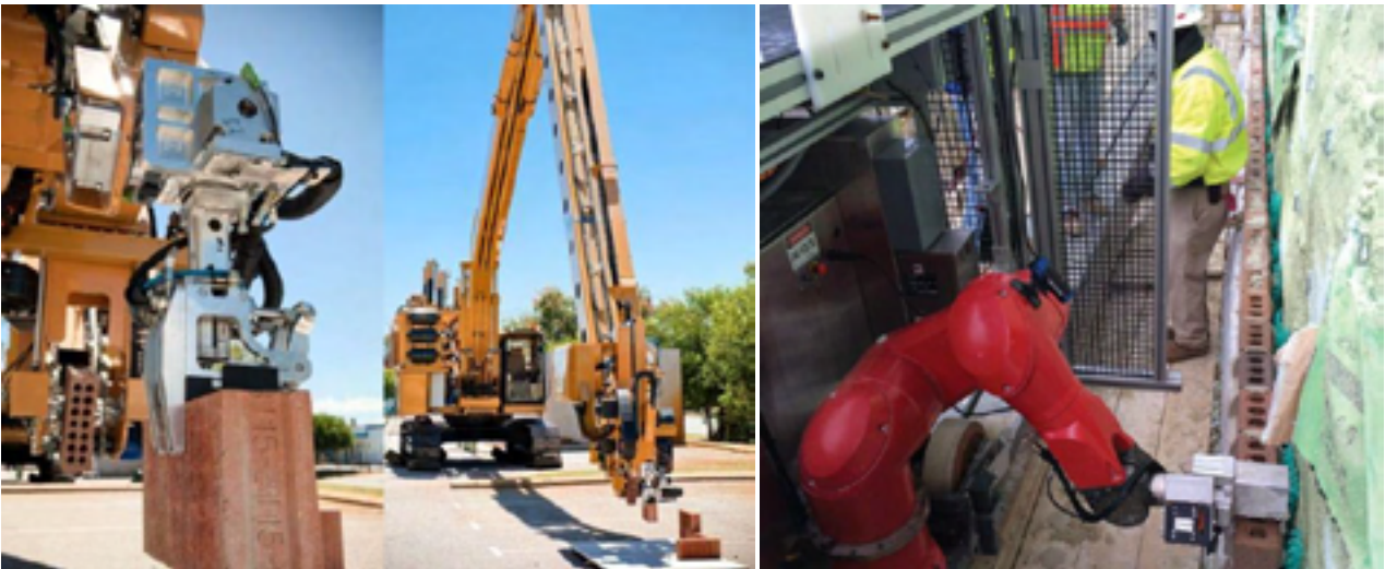
Εικόνα 2: Αριστερά: Fastbrick Robotics Hadrian και δεξιά: Construction Robotics SAM
